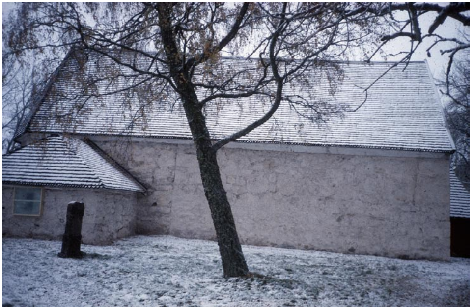
Fig. 3. Översiktsbild av norra fasaden med stötfog mellan 1700-talsmurverk och medeltida murverk väster om sakristian. Foto: Sölve Johansson 1992.
