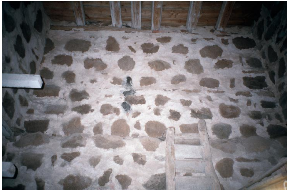
Fig. 15. Kastalen vid Benestads kyrka. Interiör med murverk fogat med ett brunaktigt kalkbruk, förmodligen baserat på Andrarumskalk. Foto: Sölve Johansson 2005.
