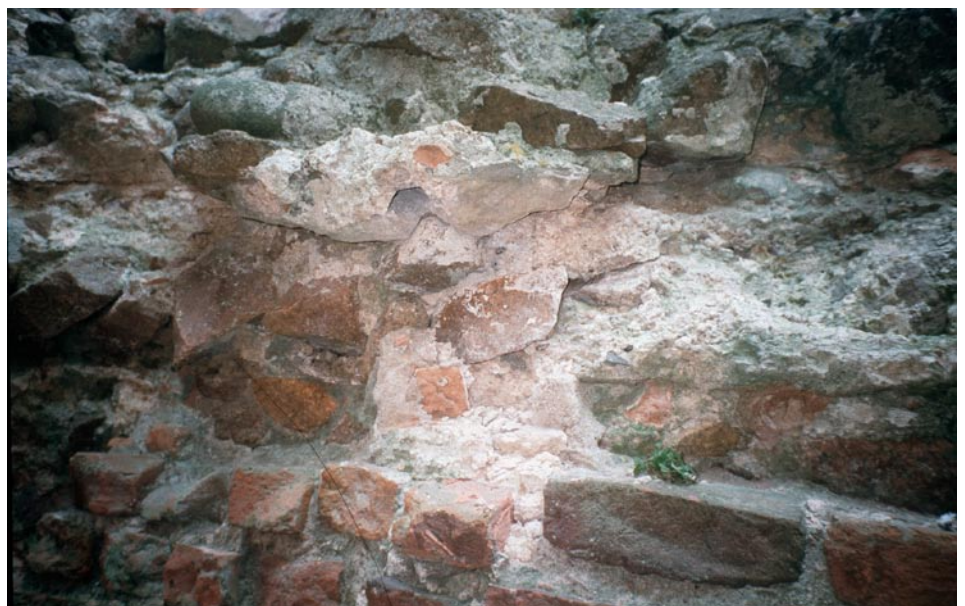
Fig. 19. Detalj från valvet till portrummet i Manteltornet på Hammershus på Bornholm med brunaktigt bruk förmodligen baserat på Andrarumskalk. Foto: Sölve Johansson 2005.
