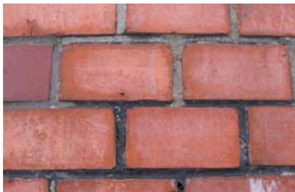
Hårdbränt fasadtegel med kopparna utåt, Örgryte kyrka.
