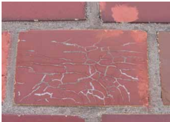
Olika typer av ytskador på beklädnadstegel, Örgryte kyrka (ovan och t h).
