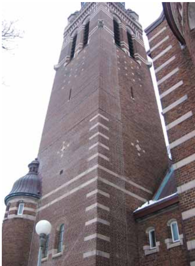
Utbytt tegelfasad åt söder på Annedalskyrkan.
